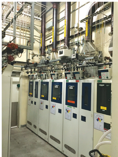
圖 3：凌力爾特晶圓製造廠裡的有毒氣體櫃處於嚴密監視之下，以確保正常執行時間
